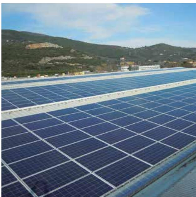
Grazie alla realizzazione di un sofisticato impianto fotovoltaico collocato sul tetto dello stabilimento, la sede di Pisa diventa il primo stabilimento verde Pentair Water in grado di produrre il 100% dell'energia necessaria alle attività produttive. Su una superficie di 11.000 m<sup>2</sup> sono stati installati 4100 pannelli solari che generano fino a 1.280.000 kWh ogni anno.
